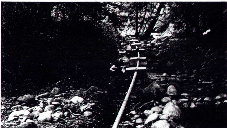
LÍNEA CON TUBERÍA DE 3" EN FIERRO GALVANIZADO INSTALADA EN LA PRIMERA ETAPA COORDENADAS: 736558.66 m E, 2281690.43 m N
